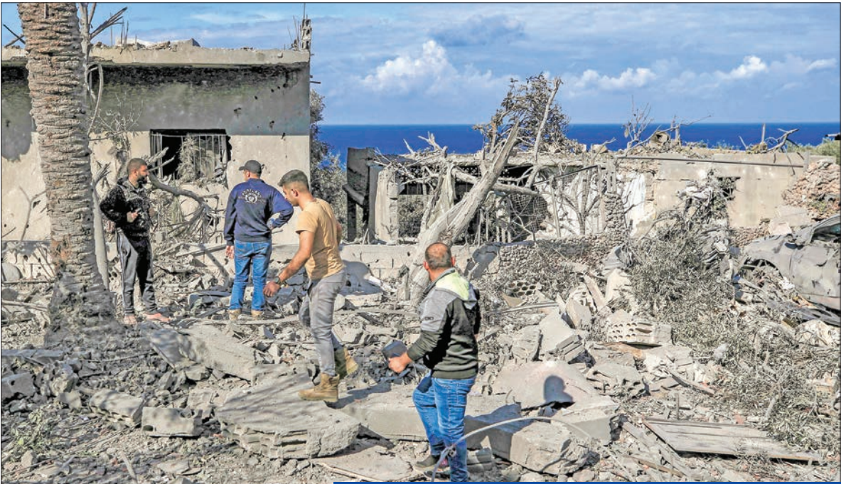
منزل دمر بقصف إسرائيلي على بلدة الناقورة الساحلية جنوب لبنان (ا ف ب)
