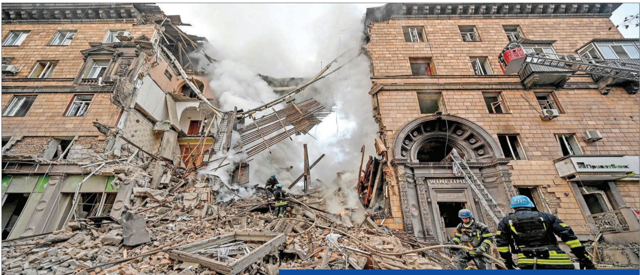
رجال إطفاء أوكرانيون في موقع تعرّض لقصف روسي في منطقة زابوريچيا أمس (أ ف ب)
