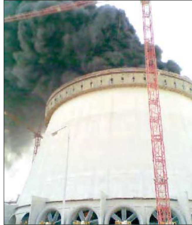
النيران تلتهم المبنى الجديد
