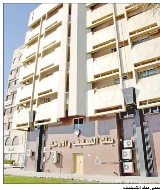
مبنى بنك التسليف
