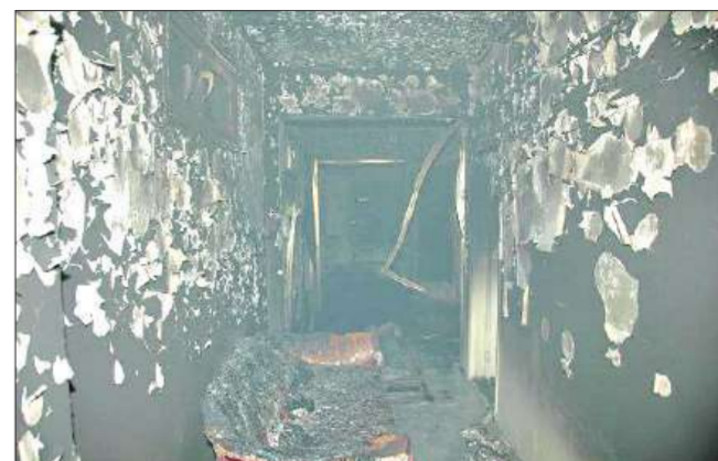
أحد محال الأثاث بعد الحريق
