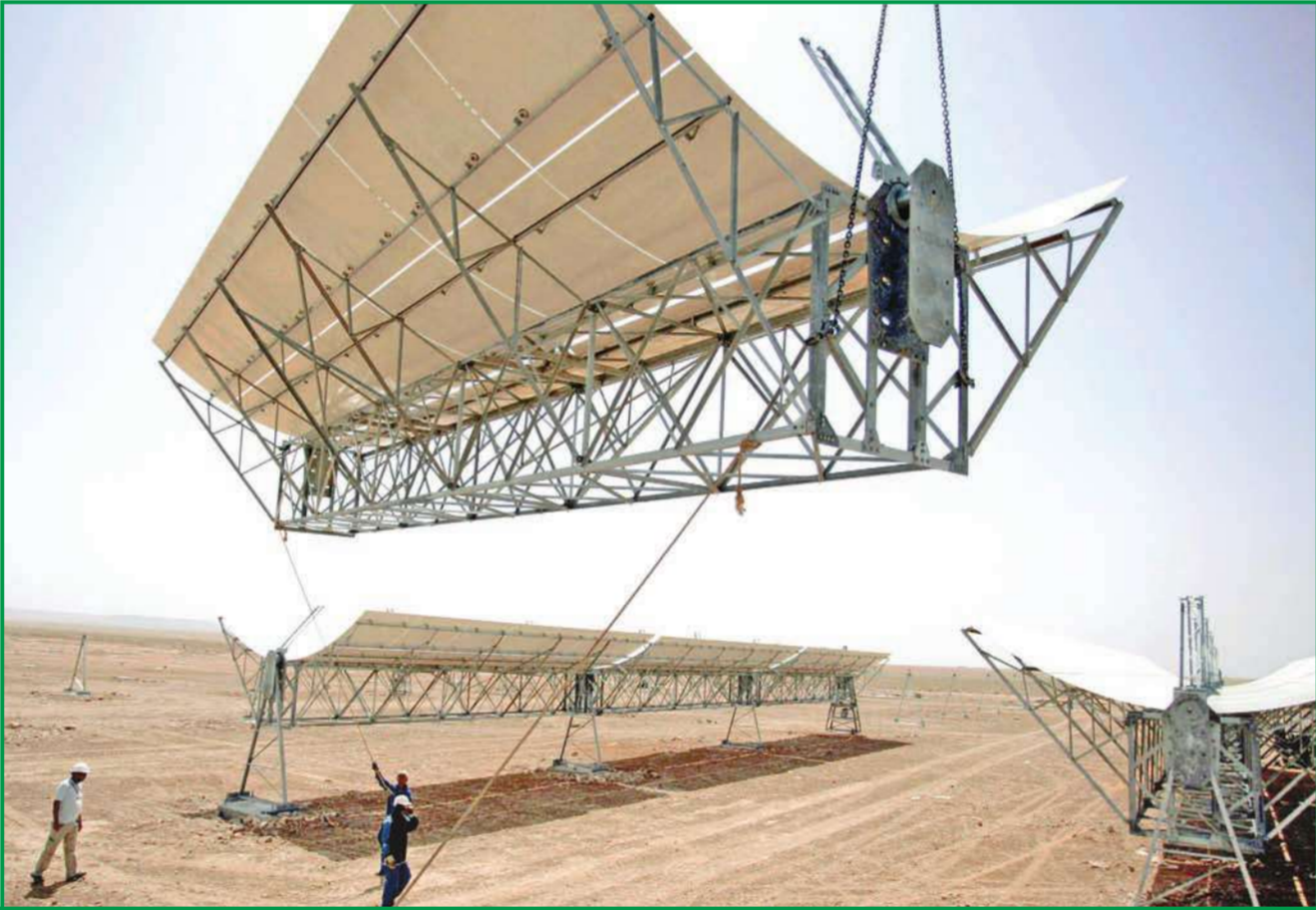
عمال بناء يقومون بتركيب وحدات الطاقة الشمسية لتوليد الكهرباء في منطقة بني مطهر في المغرب، ضمن خطة تصل قيمتها إلى 400 مليار يورو لتزويد أوروبا بالطاقة الكهربائية، ولكن بعض الخبراء ينتقدون المشروع ويرون فيه مخاطر عالية. (رويترز)
