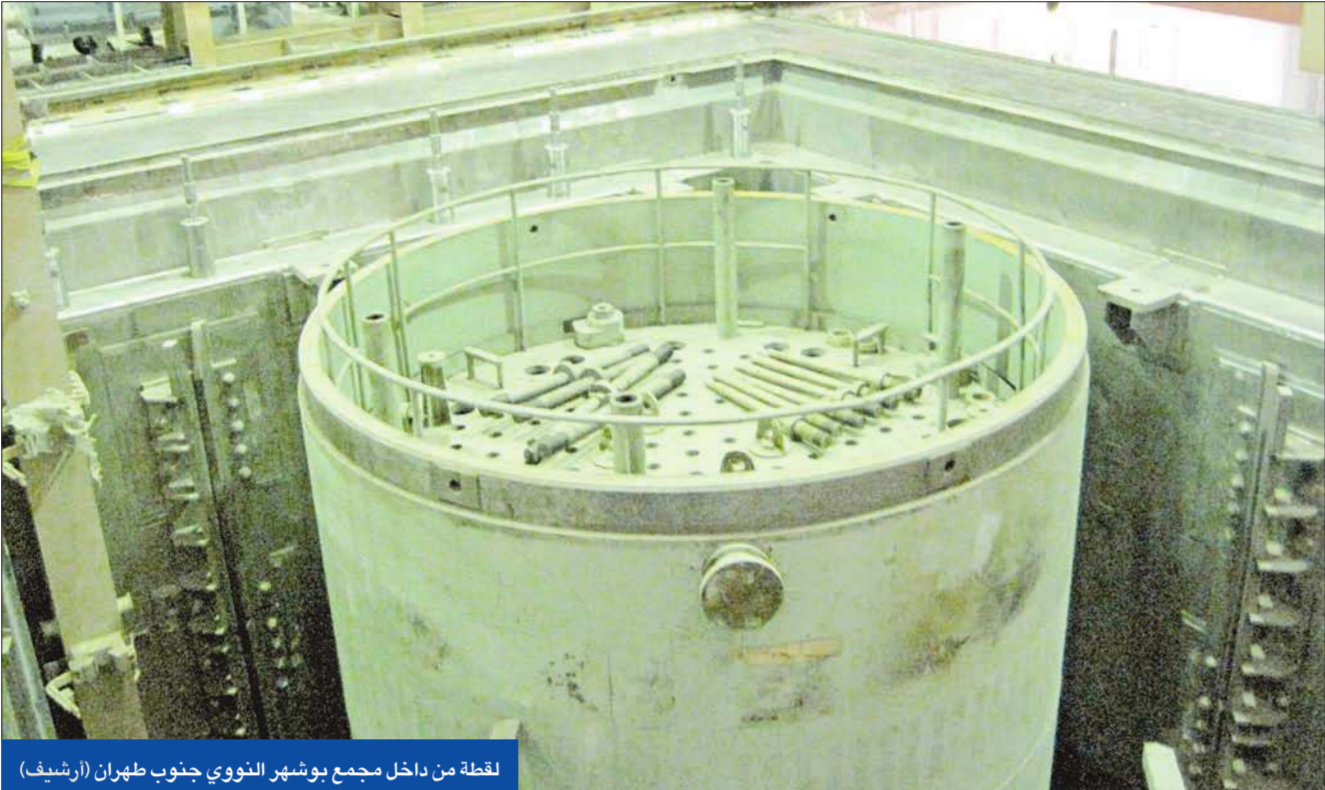
لقطة من داخل مجمع بوشهر النووي جنوب طهران (أرشيف)
