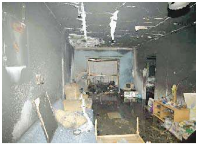
الشقة كما بدت بعد إطفاء الحريق
