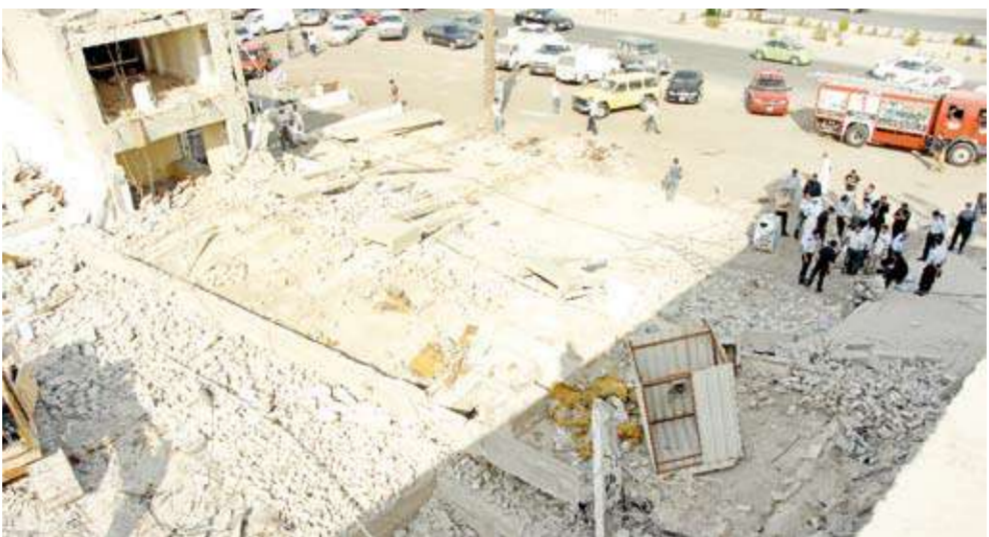
جانب من المبنى المنهار
