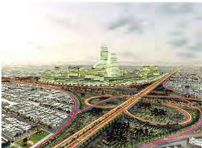
صورة كيميوتية لمركز الملك عبد الله المالي في الرياض الجاري إنشاؤه حالياً (الشرق الأوسط)
