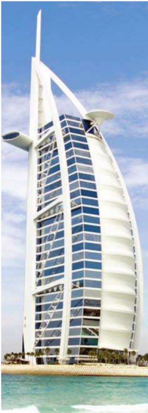
مبنى فندق «برج العرب»
