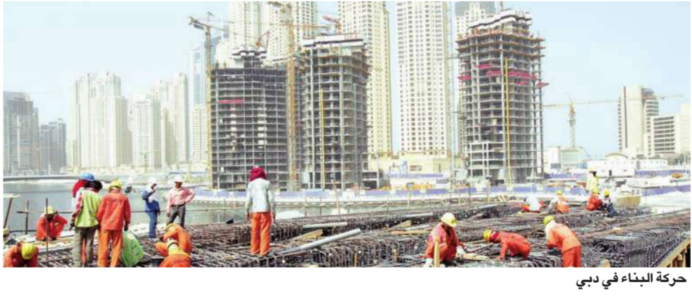
حركة البناء في دبي
